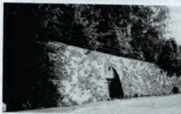
Abb. 12 Schachtfeste der ehemaligen Tiefbauschächte des ESTAV. Sächsisches Bergarchiv Freiberg, Fotosammlung Zwickauer Steinkohlenbergbau
