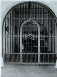
Abb. 21 Tor in der Schillerstraße. Sächsisches Bergarchiv Freiberg, Fotosammlung Zwickauer Steinkohlenbergbau
