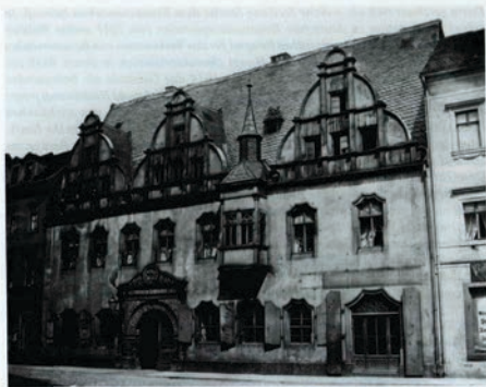
Abb. 7 Das Haus Schneeberger Straße 27/27a kurz vor dem Abriss 1884. Stadtschulch Zwickau, Foto kl. 0211/3
