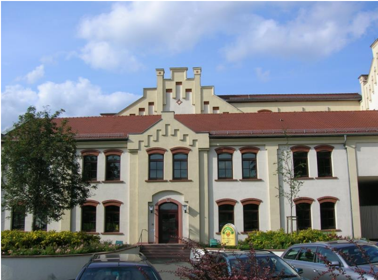
Saniertes Altbau Talstraße 1 Mauritius Brauerei GmbH
