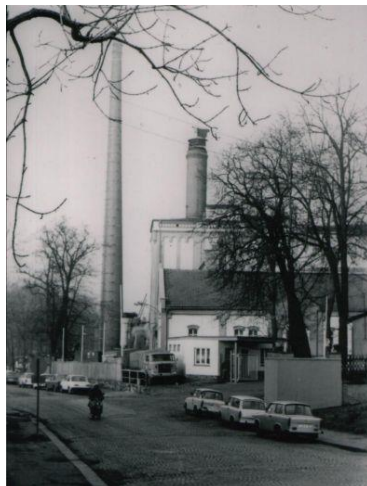
Eingang des Werkes I des VEB Braukombinates Zwickau in der Talstraße 1 Sammlung Peschke
