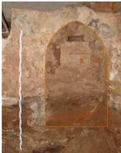
Gotisches Portal in der Rückwand des einstigen Laubenganges mit nachträglicher Vermauerung; Aufnahme Landesamt für Denkmalpflege Sachsen, 2009
