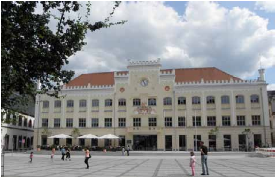
Rathaus nach der Sanierung, 2011, Aufnahme untere Denkmalschutzbehörde Zwickau
