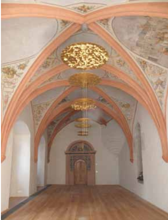
Jakobskapelle; Zustand nach der Restaurierung 2011, Aufnahme untere Denkmalschutzbehörde Zwickau
