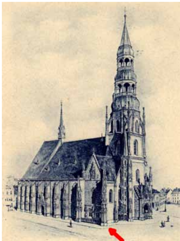
Marienkirche um 1900, der Pfeil kennzeichnet das Gottesdienstzimmer für die Taubstummengottesdienste; StadtA Zwickau Pk 0015/35
